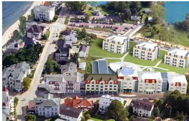
Das neue Hotel zur Post im Ostseebad Bansin mit den drei neuen Apartmenthäusern wird ab 3. Juni als KAISER-SPA die Wellness-Perle auf der Sonneninsel Usedom sein.
