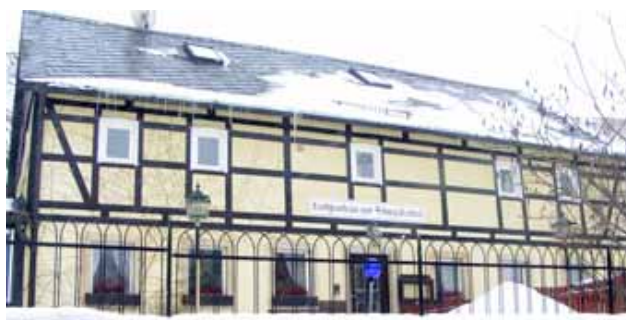
Das Landgasthaus zum Schwarzbachtal verbirgt hinter der altherwürdigen Fassade eine junge frische Gourmet-Küche.
