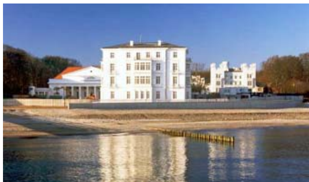
Das Kempinski Grand Hotel Heiligendamm lässt den mondänen Glanz des Seebades in der Mecklenburger Bucht wieder erstrahlen.
